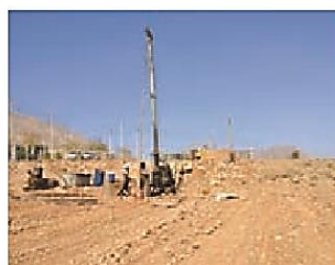
شکل ۴-۱ الف) مغزه گیری با گمانه های اکتشافی
