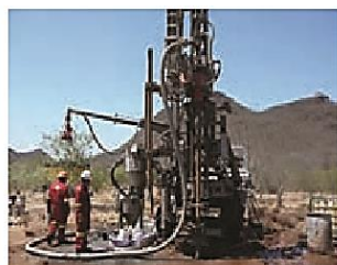
ب) دستگاه حفاری گمانه
