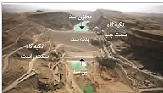
شکل ۴-۵. نمایی از بخش‌های مختلف یک سد
