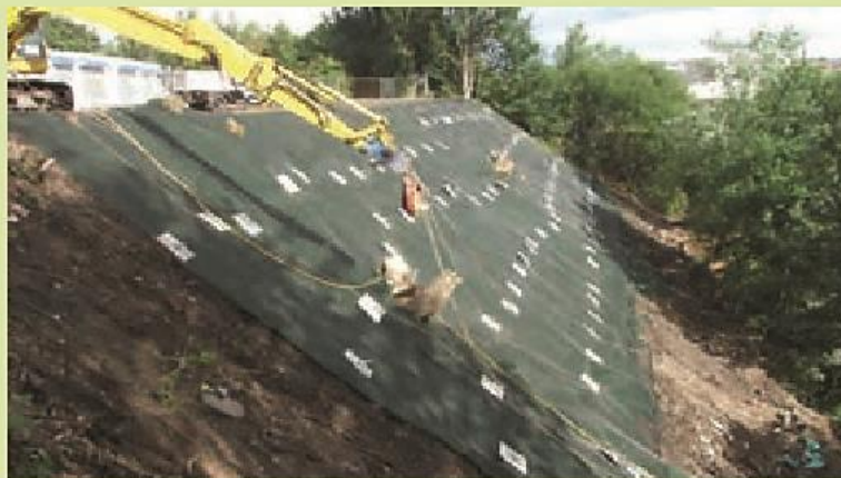
پایدارسازی شیب به روش میخ‌کوبی
